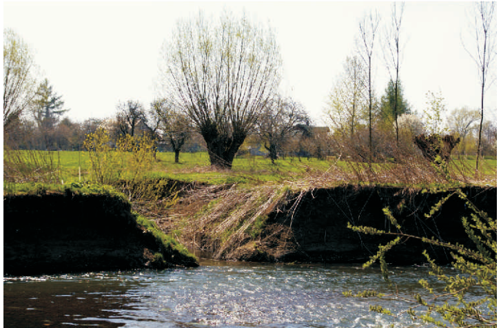
2. Ujście potoku Małka do Wisłoka
