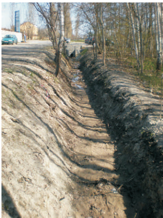
24. Odtworzony i pogłębiony rów odprowadzający wodę opadową ze zlewni do stawu
